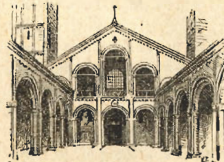
Fig. 37. — Chiesa di S. Ambrogio in Milano.
